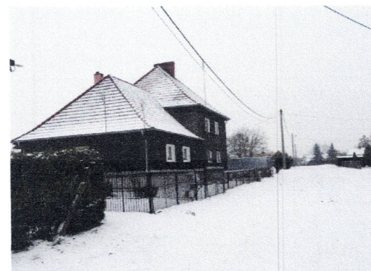
Zdjęcie nr 13 - Historyczne elementy architektury - dom prywatny, drewniany
