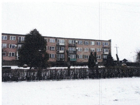
Zdjęcie nr 15 – Bloki mieszkalne
