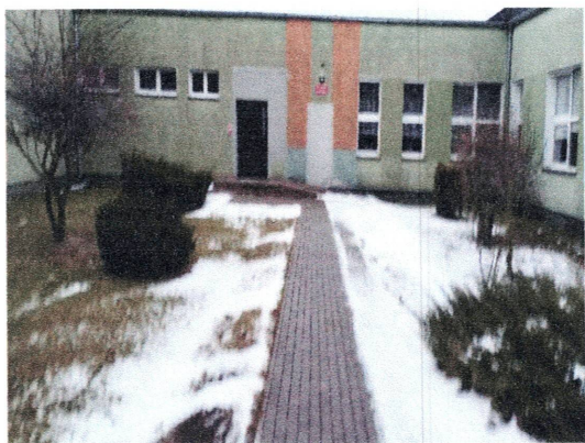
Zdjęcie nr 7 – Budynek świetlicy wiejskiej
