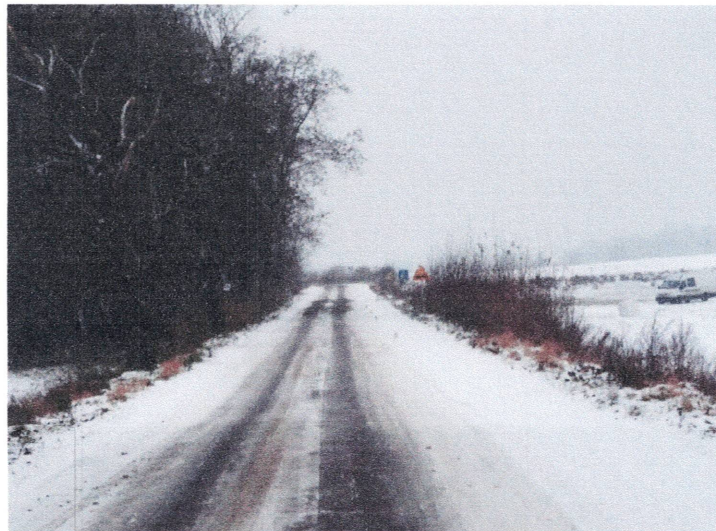
Zdjęcie nr 2 – Droga dojazdowa do miejscowości
